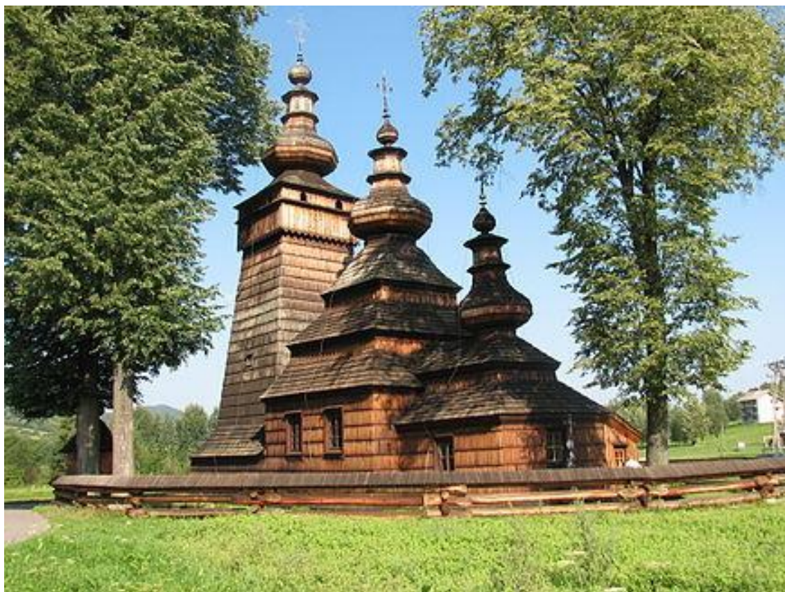
Рис.2.7. Церква святої Параскеви в с. Квятонь, Польща. Північно-західний тип будівництва
