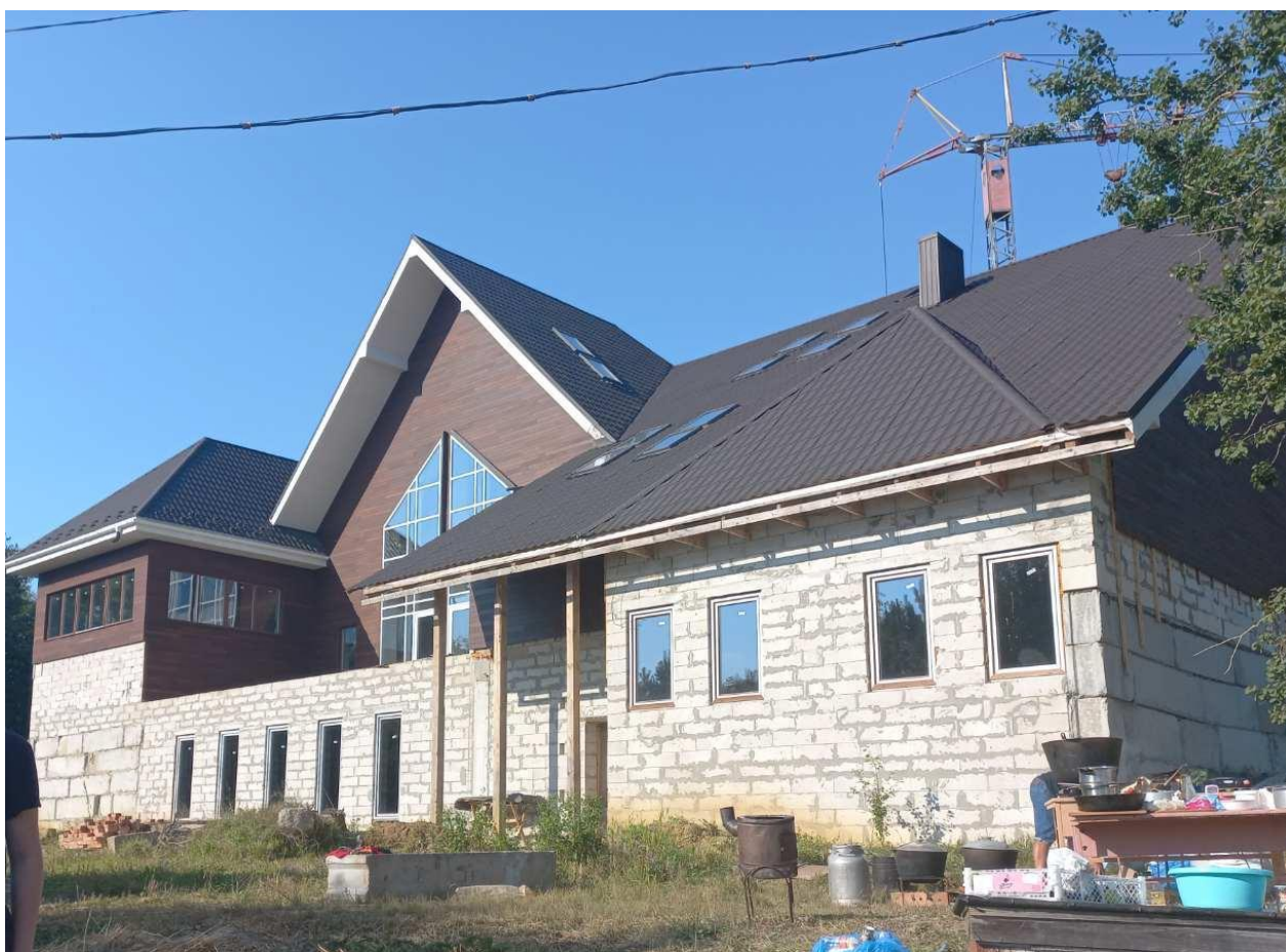
Рис.3.37. Фото будівництва музею зараз
